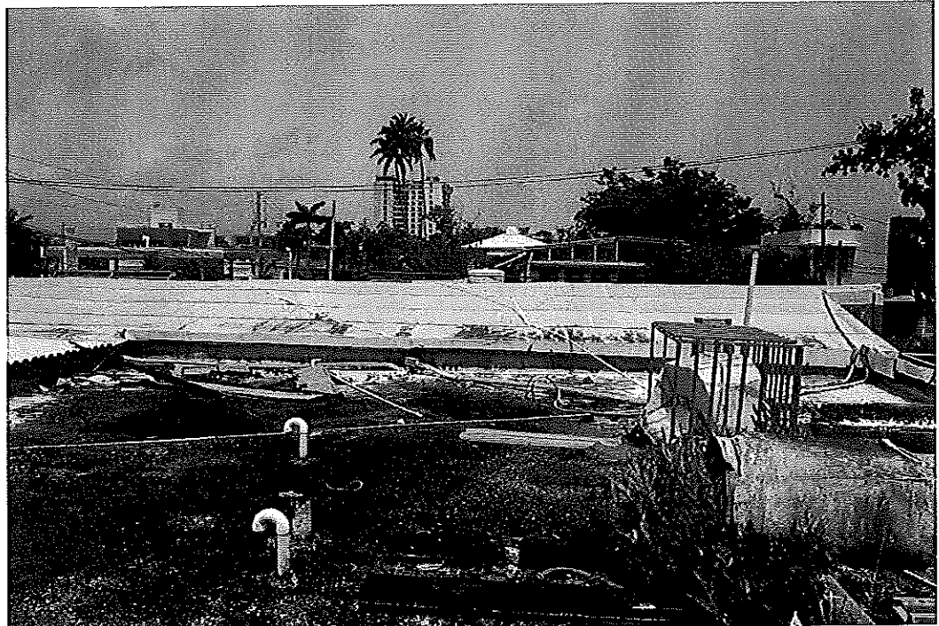
Techo de cemento del edificio principal, sin tratamiento impermeabilizante y con crecimiento vegetal sobre el mismo. Al fondo el techo de paneles de madera y cartón de techar de la ampliación oeste del edificio principal.
