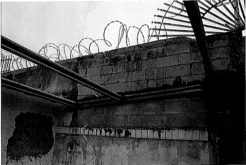
Condiciones de seguridad estructural – construcciones improvisadas de riesgo estructural en edificio accesorio posterior.
