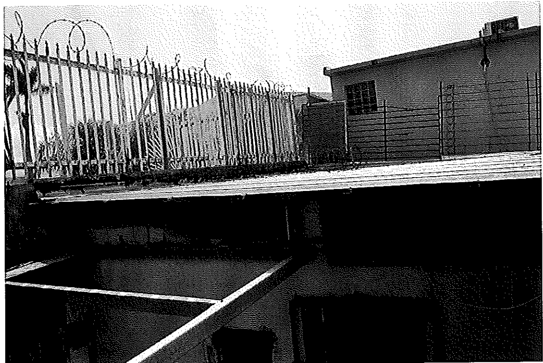
Edificio accesorio del patio lateral derecho pegado a la verja posterior de la propiedad. El sistema estructural de ese techo es en acero liviano, no estructural. Las paredes son en bloques de cemento.
