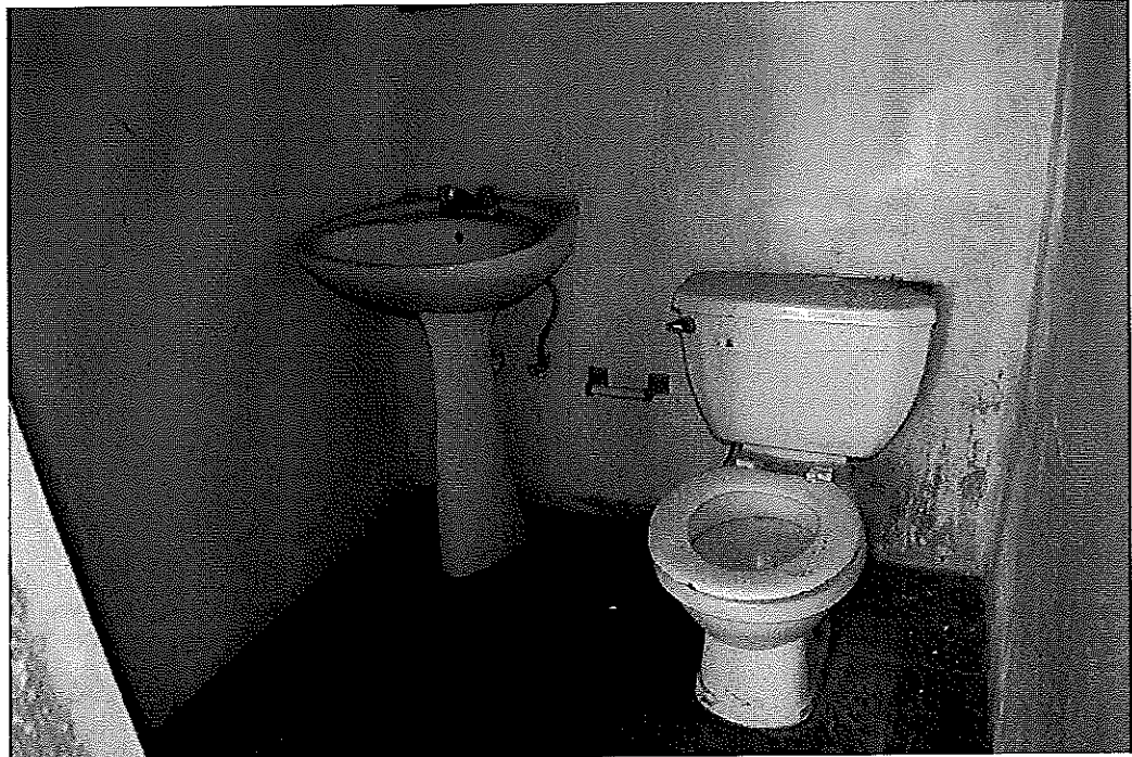
Facilidades sanitarias inadecuadas e inseguras
