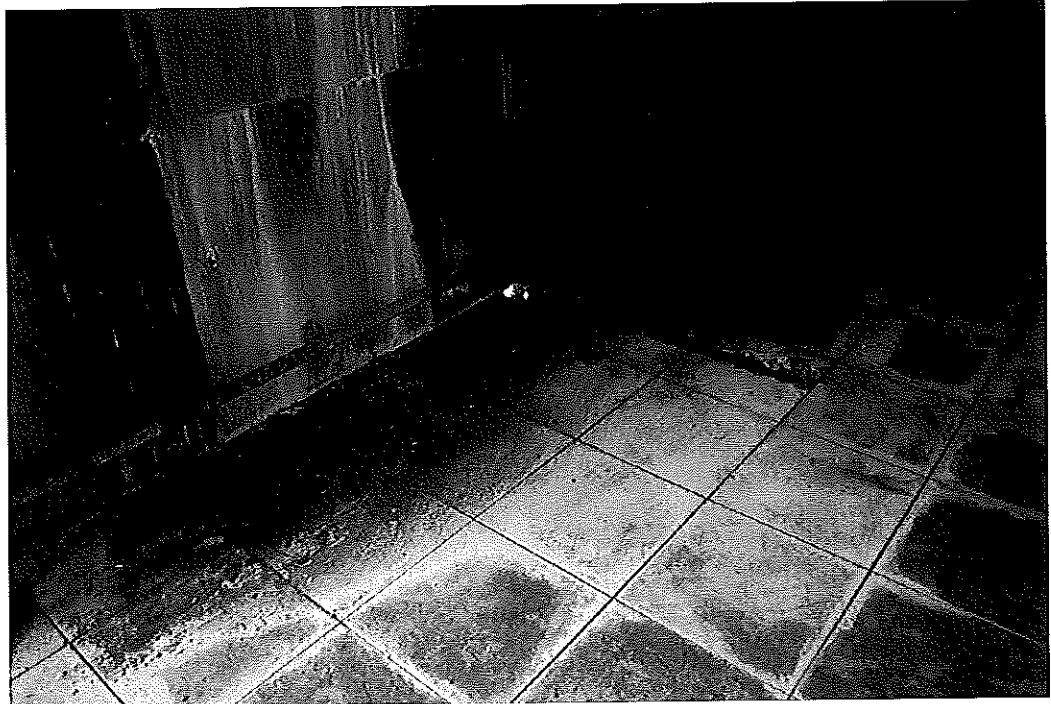
Manchas de humedad en el piso y hongo en grasa de cocina. También se nota una excavación en el piso que se usó improvisadamente para correr tuberías de equipos de cocina al exterior.
