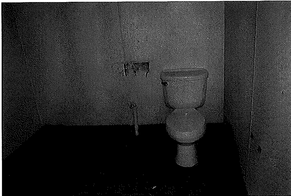
Baños desmantelados e inoperantes.
