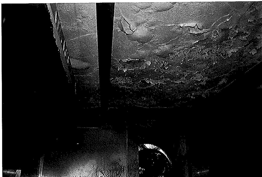
Condición de humedad y refuerzo del techo de cocina.
