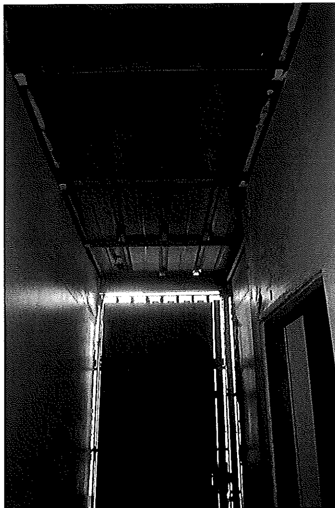
Techo de metal liviano, no estructural sostenido sobre las paredes de bloques en el edificio accesorio del patio lateral derecho.
