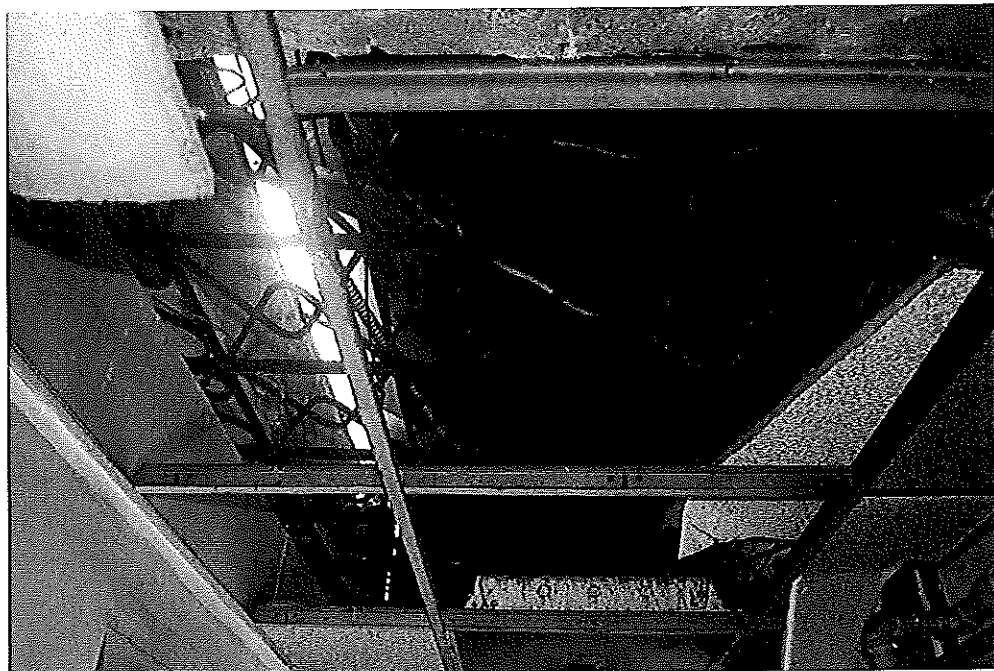
Rejas usadas en el techo de madera y paneles acústicos rotos.
