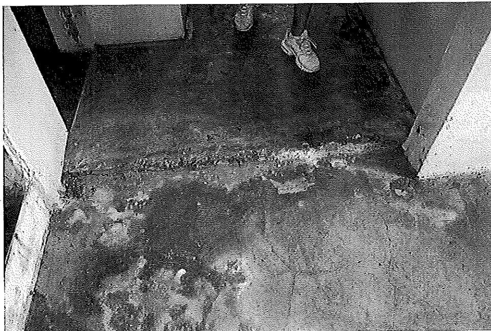
Condición de pisos en edificio accesorio de patio lateral derecho.
