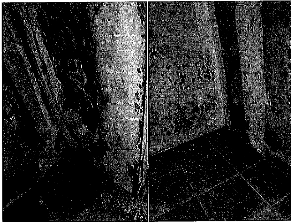
Condición de Salud – Hongo negro por humedad en paredes y techo.
