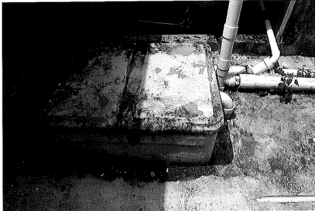
Tanque de trampa de grasa de restaurante chino en patio posterior
